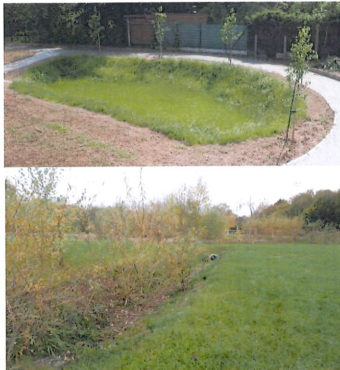
Figure 10 : exemples d'aménagement de bassins d'infiltration 8
